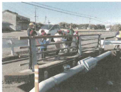
（画像1）危険箇所の確認
